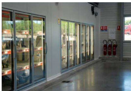
Pour le picking et le stockage de la commande de produits surgelés : possibilité de prise à la livraison soit en zone froide, soit en zone ambiante (système de sas avec portes vitrées).
