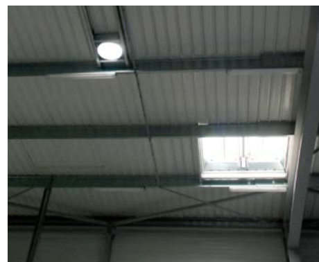
Prises de jour en toiture
