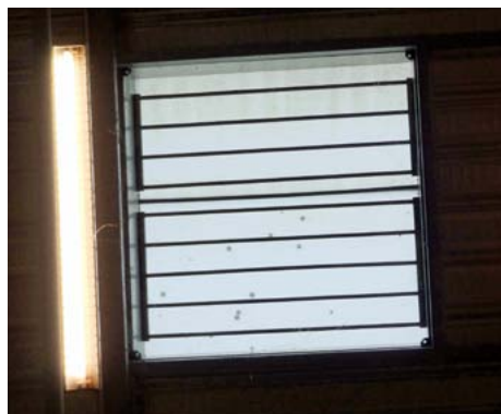
Barreaudage en sous-face d'un lanterneau
