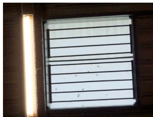
Barreaudage en sous-face d'un lanterneau
