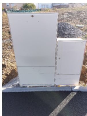
Coffret compteur électrique
