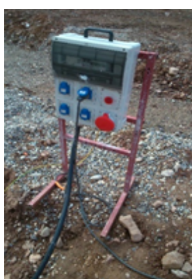
Coffret provisoire de chantier
