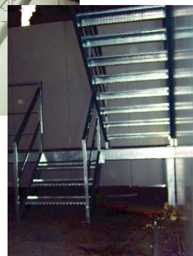
Escaliers définitifs mis en place dès la phase travaux
