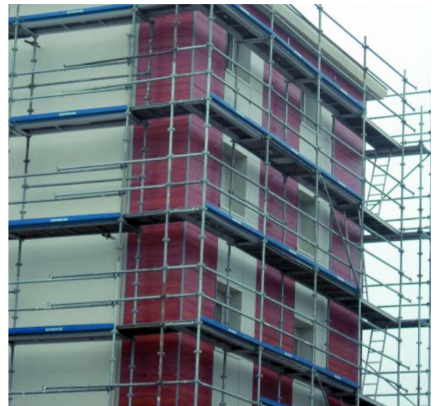
Échafaudage commun à tous les lots
