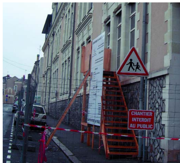
Escalier d'accès provisoire
