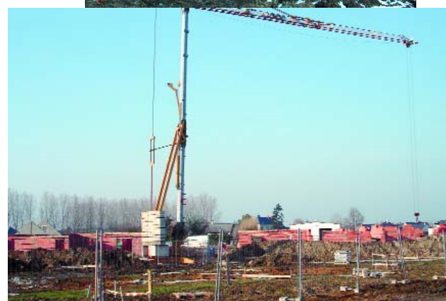
Plateformes et voiries en bon état
