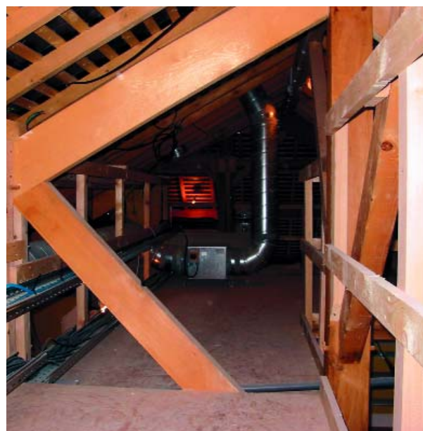
Accès sécurisés dans les combles
