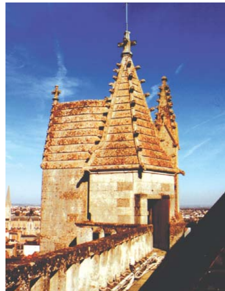
Contrefort d'angle des tours : porte d'escalier et cheminement d'accès à la couverture.
