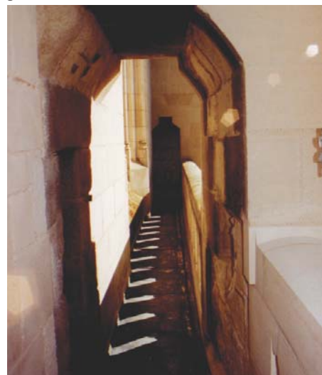
Passage de pilier pour le triforium.
